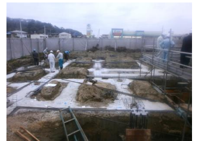
〔角田消防署丸森出張所の建築工事〕
