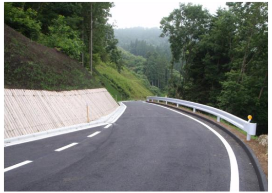
【開通なった「明光沢2号線」の状況】
