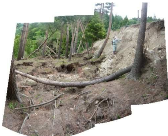
被災状況(山腹頭部滑落崖)
