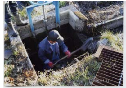
水路樹土砂上げ
