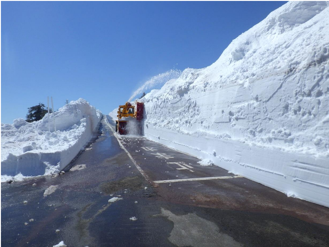
(主)白石上山線 除雪状況 (H31. 4. 16撮影)
