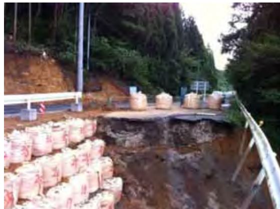
応急工事実施状況
