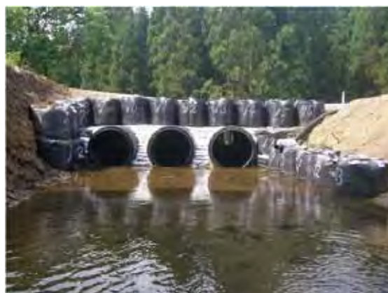
平成 23 年 5 月 31 日 応急工事完了
