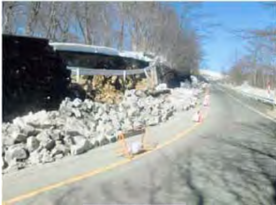
ブロック積崩壊
