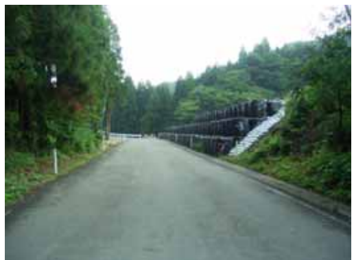
平成 23 年 5 月 31 日 応急工事完了
