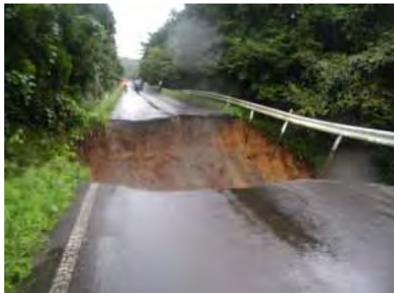
平成23年9月21日 被災(増破)
