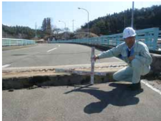
(一) 南蔵王白石線 石淵橋 (白石市)
