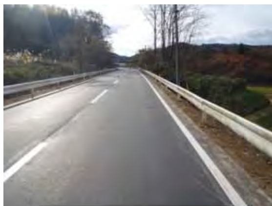
平成 23 年 11 月 25 日 復旧完了
