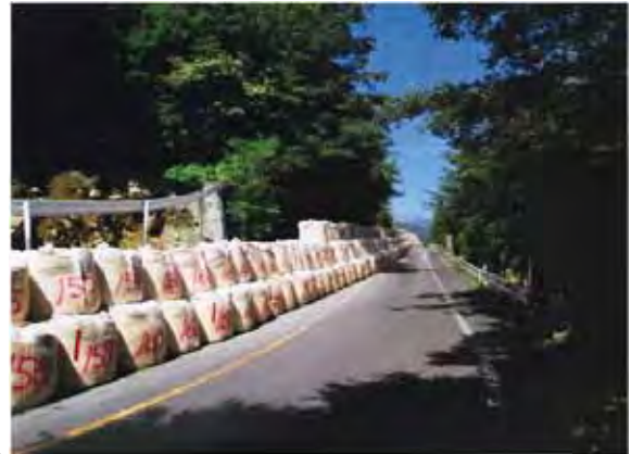
平成 23 年 6 月 21 日 応急工事完了
