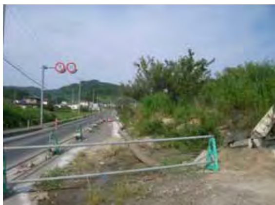
(国)113号 白石市郡山(2)地内 法面崩壊
