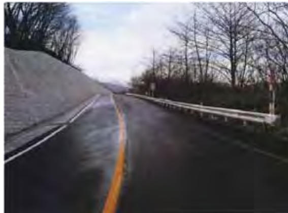
平成 23 年 11 月 30 日 復旧完了
