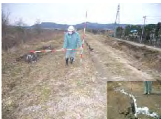
一級河川白石川 柴田町下名生地内 亀裂・沈下
