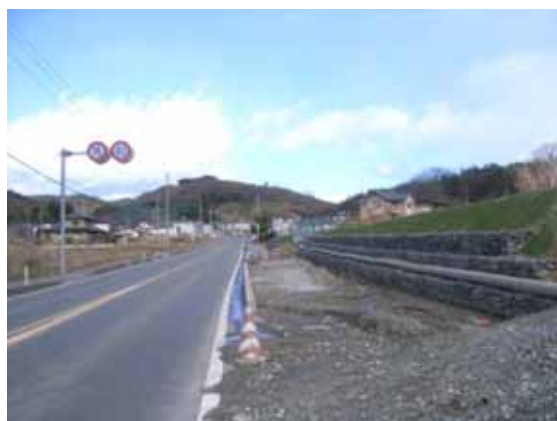
平成 23 年 11 月 30 日 復旧完了
