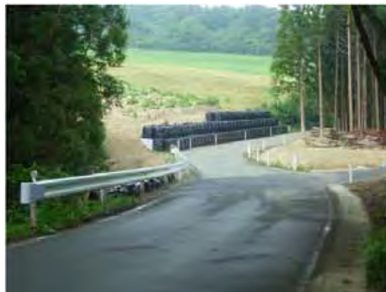
平成 23 年 5 月 31 日 応急工事完了
