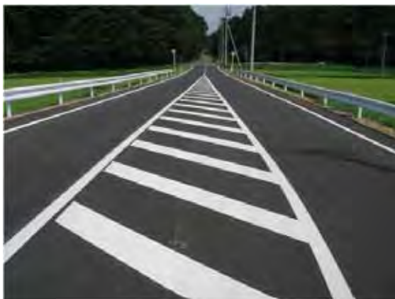
平成 23 年 7 月 20 日 復旧完了
