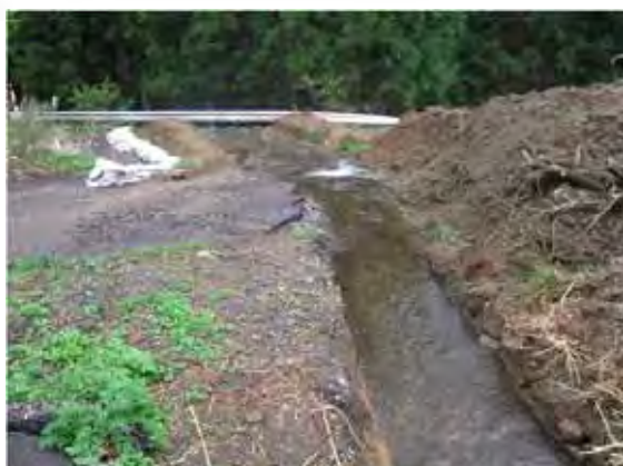
(国)457号 白石市福岡深谷地内 路面流出
