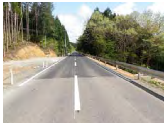
平成24年4月27日 復旧完了
