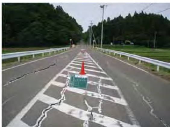
(主)丸森柴田線 丸森町金山字長根地内 亀裂
