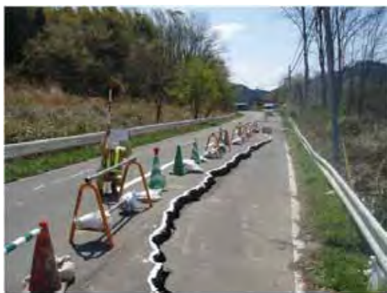
(一)大河原高倉線 角田市毛萱字宮ノ下地内 沈下
