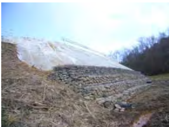
平成 23 年 12 月 20 日 復旧完了
