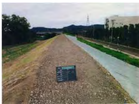
平成 23 年 8 月 23 日 復旧完了
