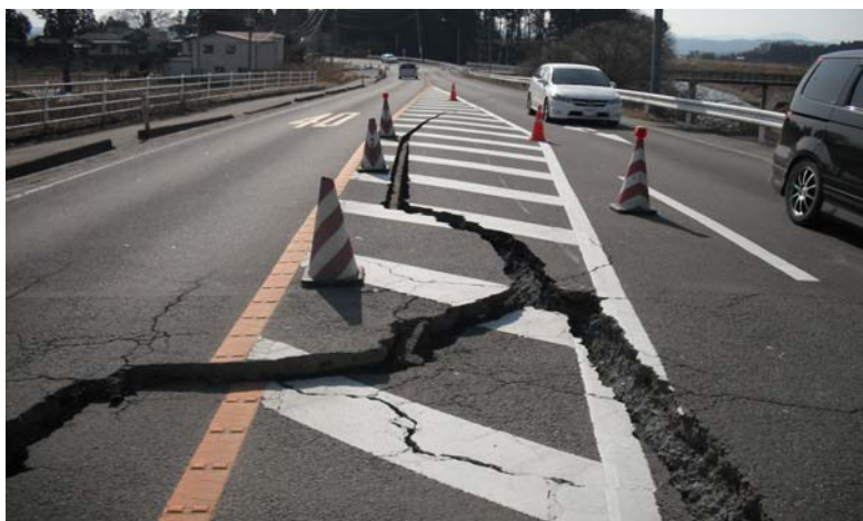
路面に発生した沈下によるクラック(交差点から南側)
