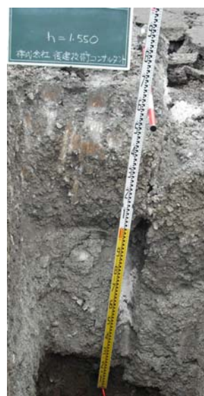
(深さ1.6mまで達した亀裂)
