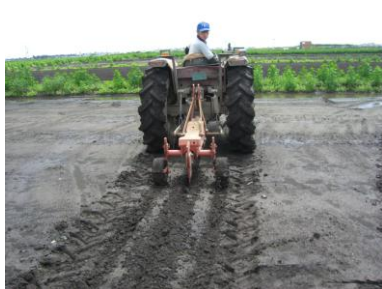
除塩実証試験:暗渠設置(名取市)
