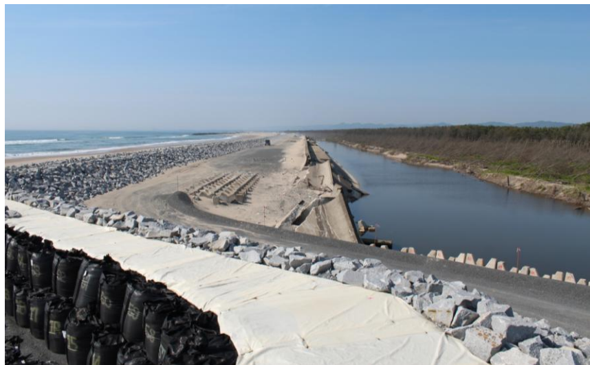
仮復旧後の状況（平成24年6月2日）
