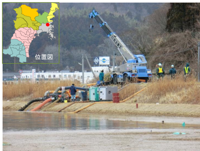
応急用ポンプ(地方農政局からの借り入れ)による浸水農地の排水対応 飯野川地区(石巻市)
