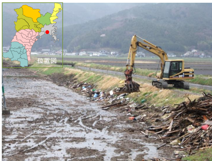
農地のガレキ撤去 大瓜地区(石巻市)
