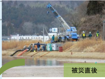
①被災農地復旧状況 (石巻市:飯野川地区)
