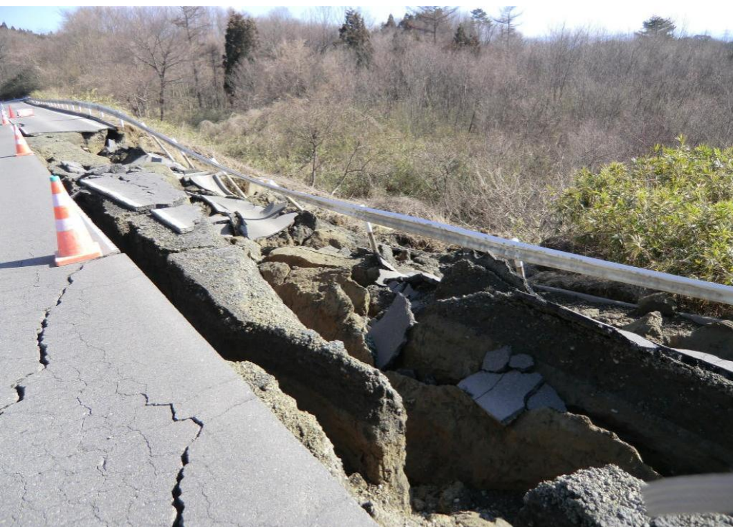
広域営農団地 農道仙南線 (白石市・川崎町・ 蔵王町)
