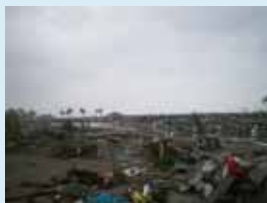
⑪農地被災状況 (仙台市: 大堀排水機場近辺)
