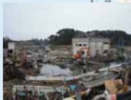
⑦排水機場被災状況 (東松島市: 中下排水機場)
