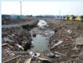
⑬排水路被災状況 (亶理町: 枝川排水路)
