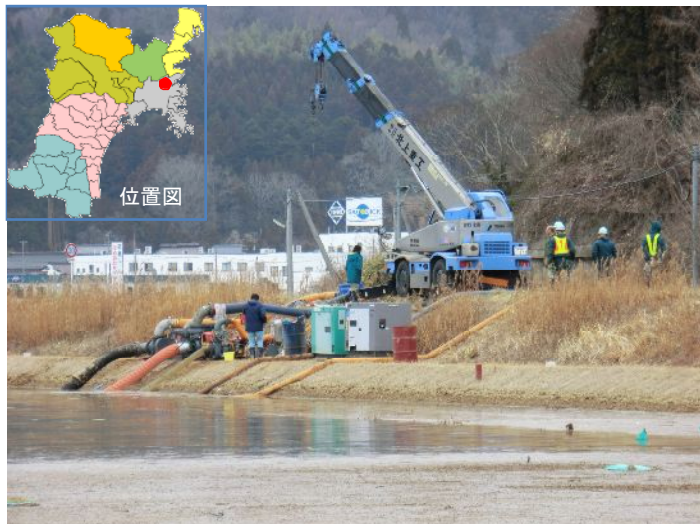
応急用ポンプ(地方農政局からの借り入れ)による浸水農地の排水対応 飯野川地区(石巻市)
