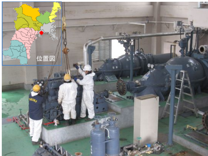
機場応急復旧状況 立沼排水機場(東松島市)
