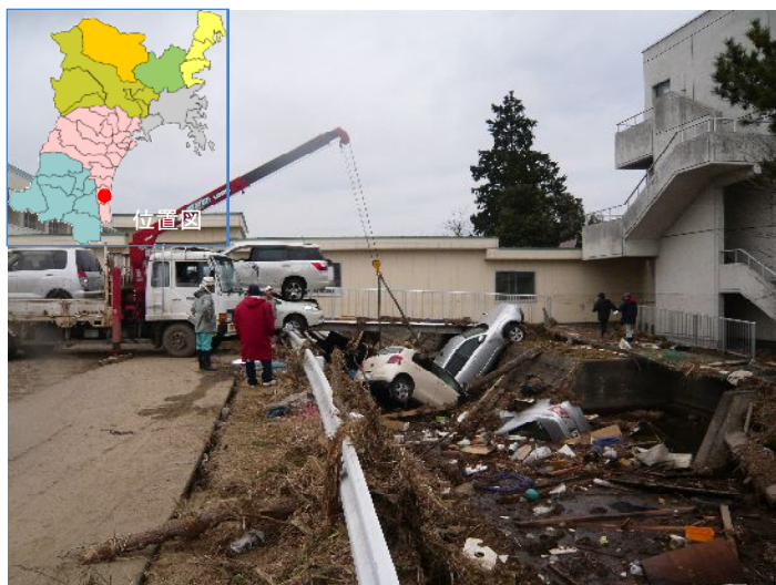
幹線排水路のガレキ撤去作業 舟入川排水路(亶理町)
