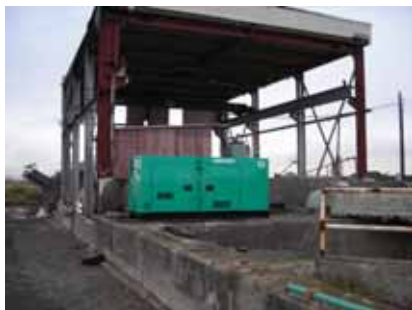
大堀排水機場の仮復旧(仙台市)
