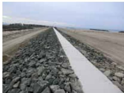
農地海岸の2次復旧完了(巨理町)
