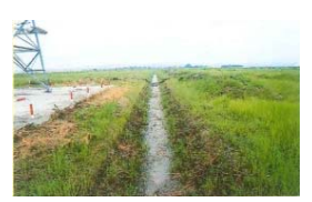
整備前の土水路
