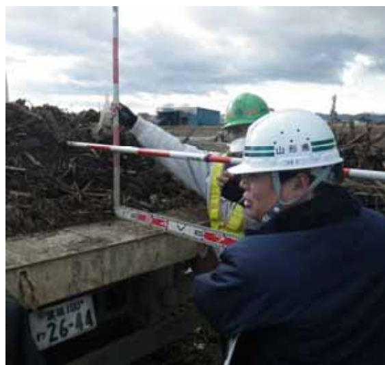
工事の管理(仙台地方振興事務所)
