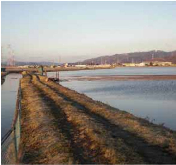
被災後(平成23年3月)
