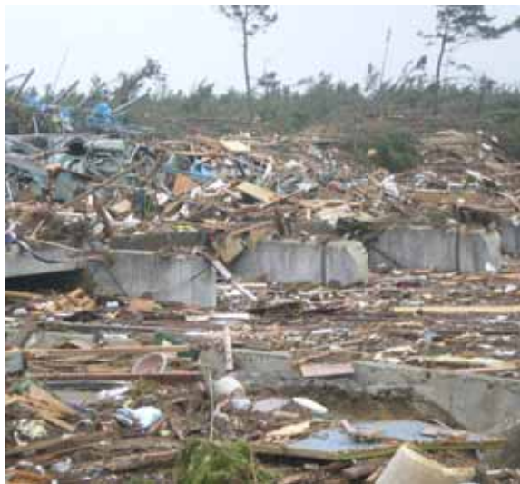
被災直後(平成23年3月15日)
