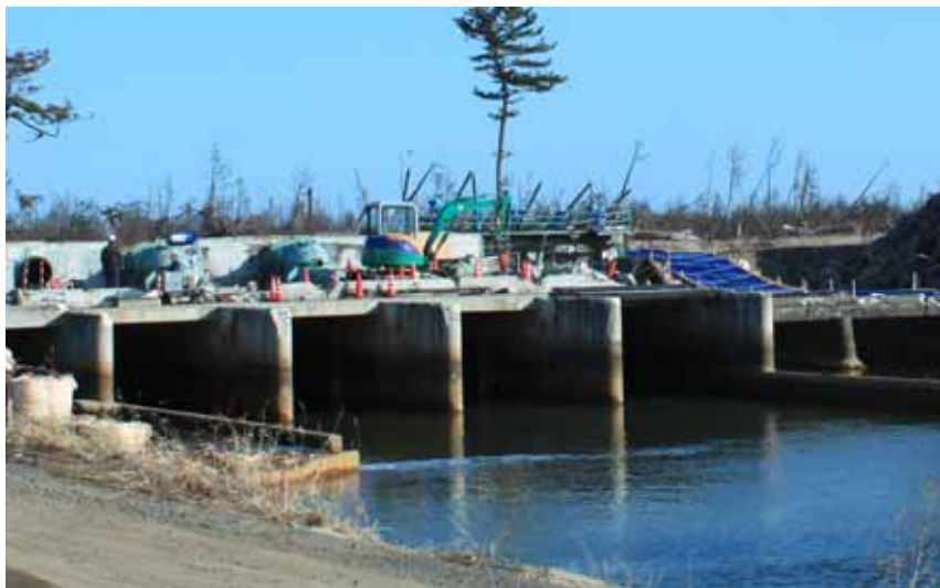
機場復旧工事(平成24年3月14日)
