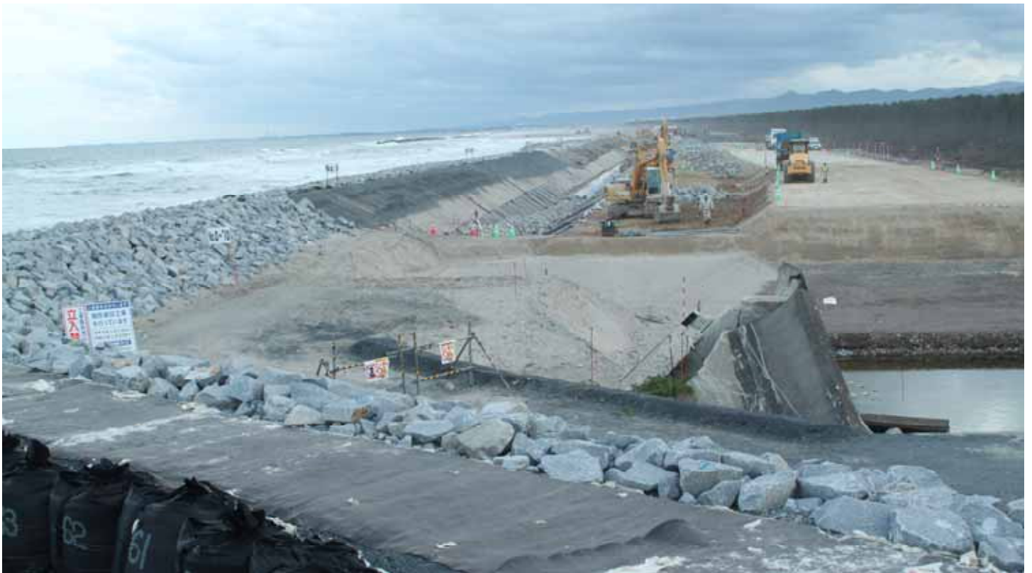
現在の状況(本復旧工事中)(平成24年9月22日)
