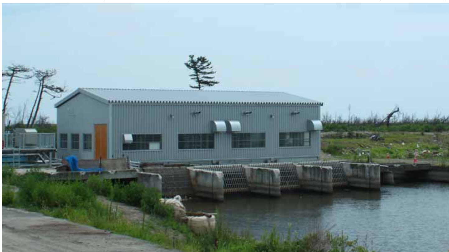
仮復旧された建屋(平成24年9月20日)
