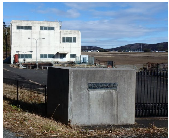
前谷地揚水機場
