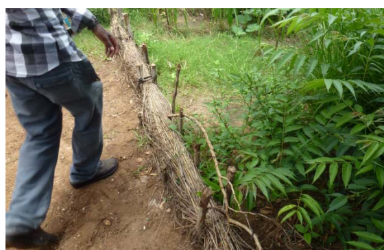
移転技術である粗朶工法を応用した土壌浸食防止対策(ンチュウ県)
