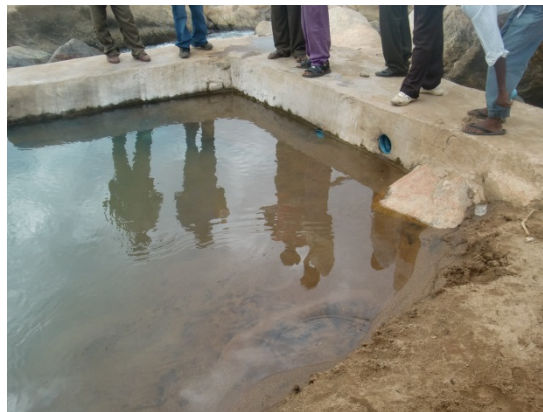
堆砂により機能が低下した取水堰(テッサ県)
