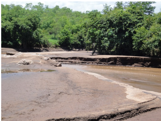
取水堰上流の堆砂(ザリマ県)
