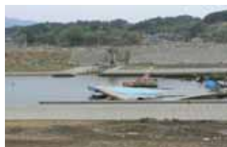
▲写真 県営農業用施設災害復旧事業 十郎衛門頭首工被災状況 気仙沼市
