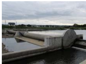
▲写真 県営災害復旧事業 秋山頭首工ゴム堰破損状況(栗原市)
