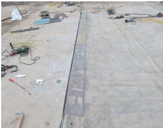
▲写真 圧着完了
