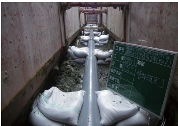
▲写真 集水施設布設替 完成
