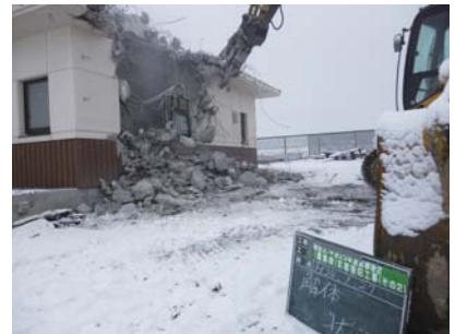
▲写真 処理場解体
