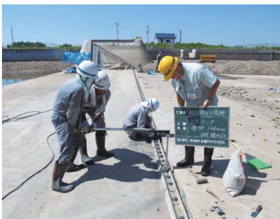
▲写真 固定金具トルク確認
