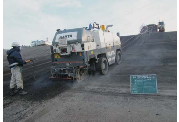
▲写真 舗設状況①
