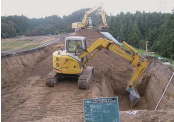
▲写真 堤体の築立
