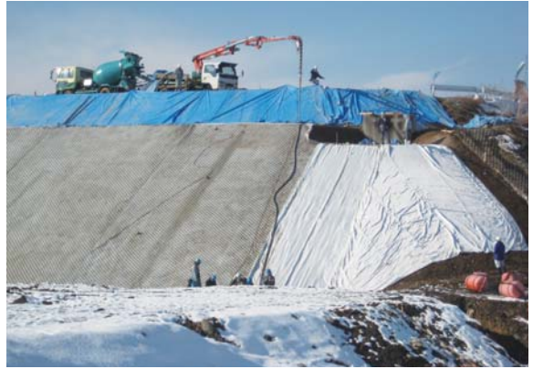
▲写真 護岸施工
