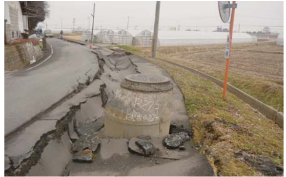
▲写真 管路及びマンホールの破損状況
