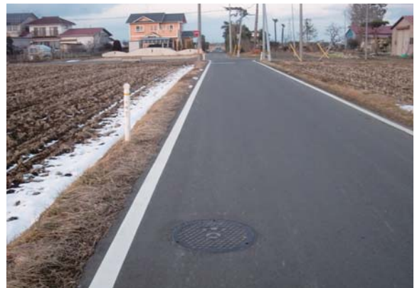
▲写真 マンホール復旧 完成
