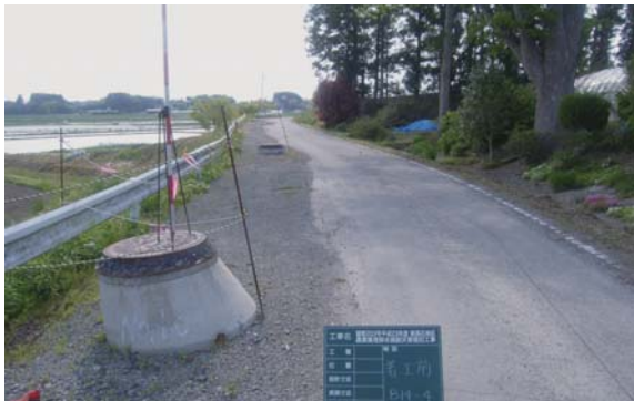
▲写真 ①着手前
