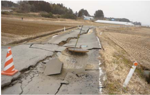
▲写真 管路及びマンホールの破損状況
