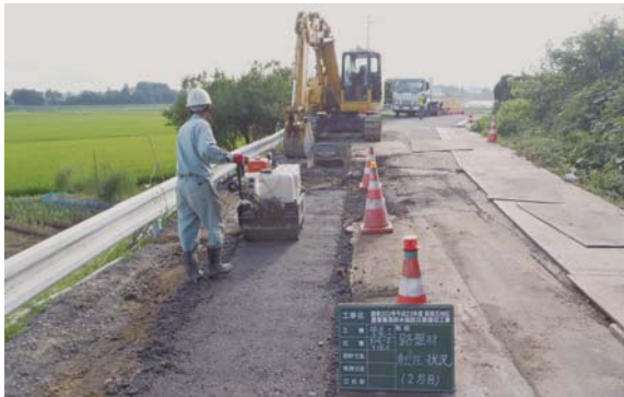
▲写真 ③埋戻・路盤工
