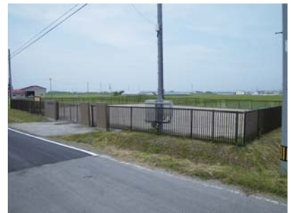
▲写真 処理場整地
