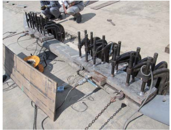
▲写真 熱圧着状況
