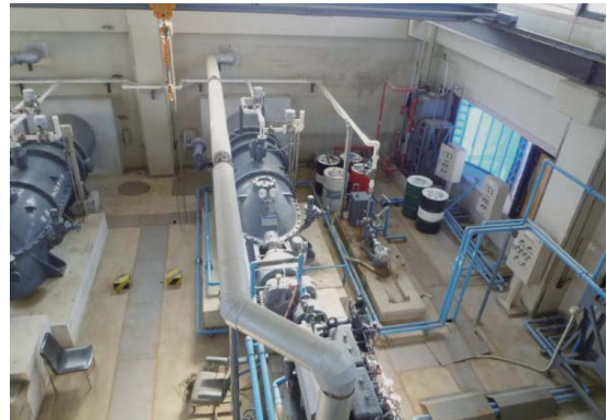
▲写真 応急復旧後の排水機場 (H24. 1)
