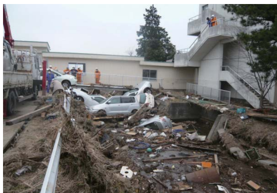
▲写真 被災直後の排水路（H23. 3）
