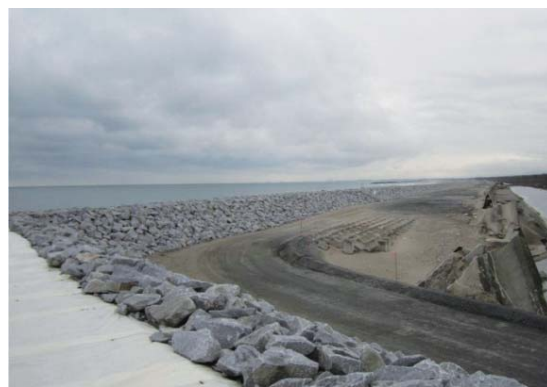
▲写真 国による応急仮堤防設置 (H23. 10)
