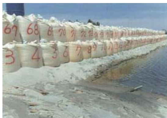
▲写真 農地海岸の応急復旧 (県施工 H23. 4)
