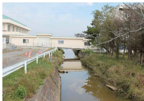
▲写真 災害廃棄物撤去後の排水路（H23. 11）
