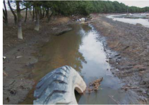
▲写真 大曲機械排水路（東松島市）
