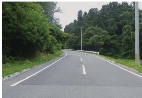
▲写真 復旧完了状況
