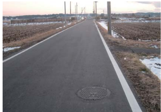
▲写真 復旧後の管路施設 (H24.12)
