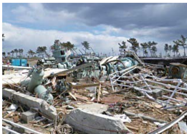
▲写真 二郷堀排水機場（仙台市）
