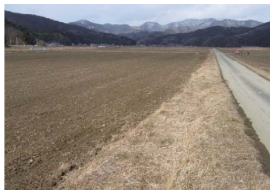
▲写真 農地復旧後（H24. 1. 24）
