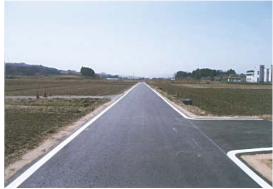
▲写真 復旧完了状況
