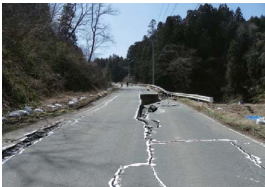
▲写真 農道の被災状況(栗原市一迫 松の木地区)
