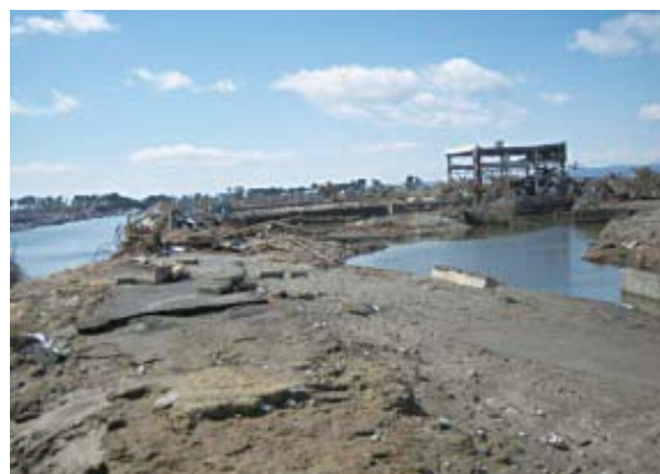
▲写真 大堀排水機場（仙台市）
