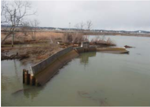
▲写真 大曲排水機場（東松島市）
