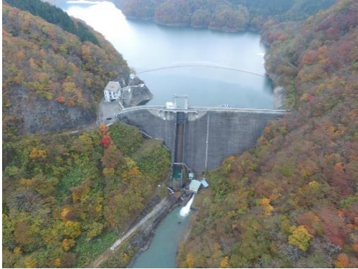
栗駒ダム（昭和37年竣工）
