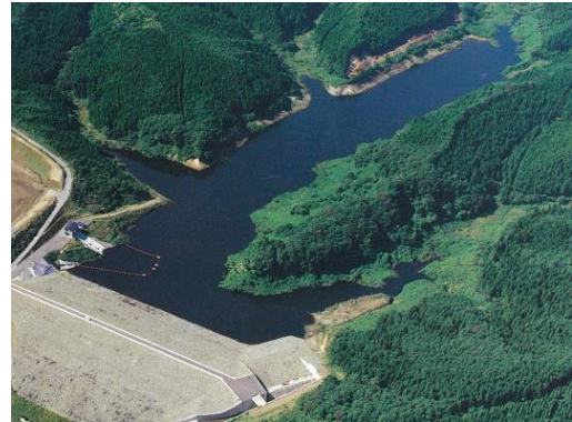
菅生ダム（平成8年竣工）
