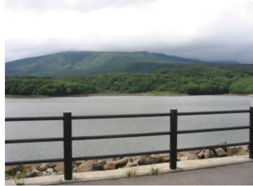
川原子ダム（昭和44年竣工）
