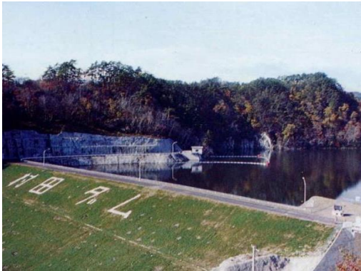
村田ダム（昭和54年竣工）
