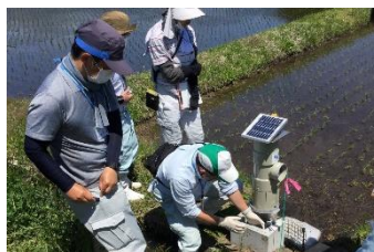
図4 遠隔水管理制御装置の設置
