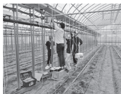
環境測定機器の取付
