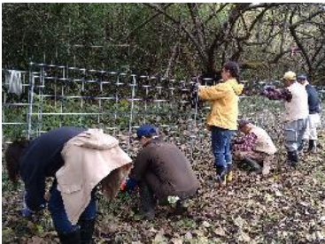
鳥獣被害防止に向けた侵入防止柵の設置
