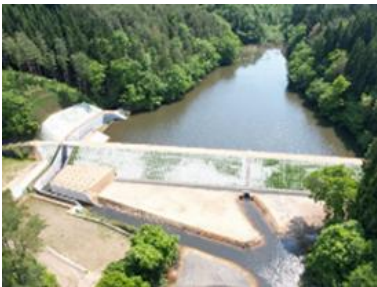
防災重点農業用ため池の ていたい 堤体の補強工事
