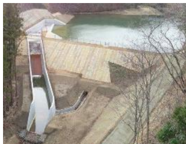
防災重点農業用ため池の防災工事
