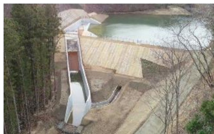
防災重点農業用ため池の防災工事
