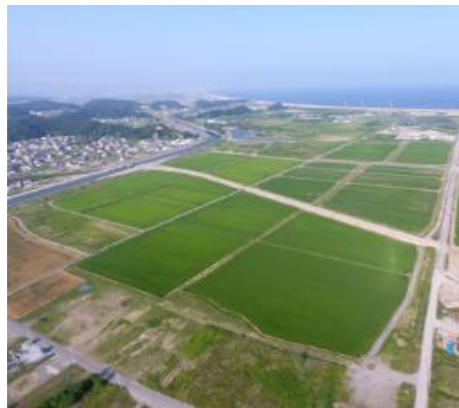
奥松島地区洲崎工区 営農再開
