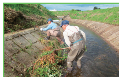
多面的機能支払交付金 土砂払い作業
