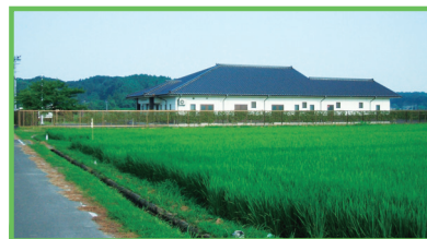
農業集落排水事業 富岡地区
