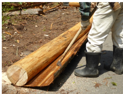
▲木の皮を剥いだあと、防腐剤を塗ることで雨や虫による傷みを防ぎ、5年程使えます
