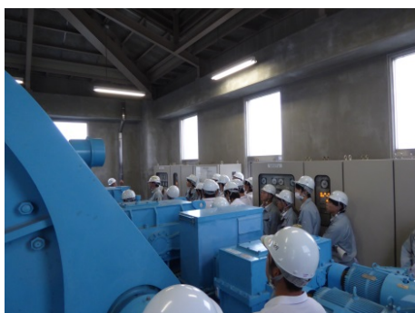
▲桑折江頭首工 ゲート操作室
