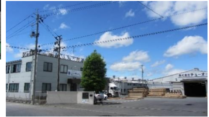
〈事務棟・工場外観〉
