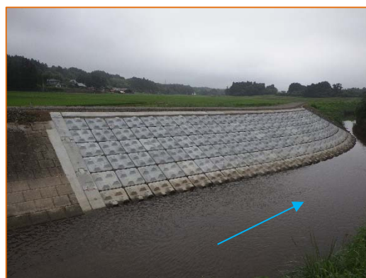
築堤護岸完成
