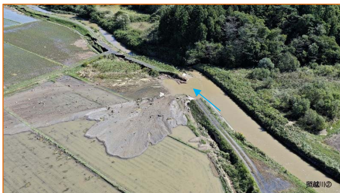
視察箇所破堤状況
