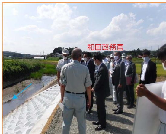
復旧した護岸と通常時の河川状況を確認
