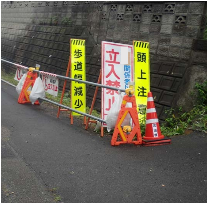
バリケード設置状況
