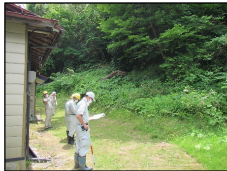
南郷原（急傾斜地崩壊危険箇所）
