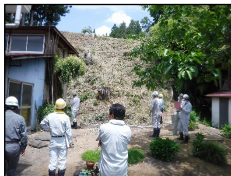
町館の1（急傾斜地崩壊危険箇所）
