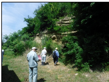
上吉目木（急傾斜地崩壊危険箇所）
