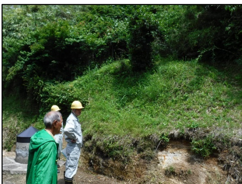
【一迫】宝領の2（急傾斜地崩壊危険箇所）
