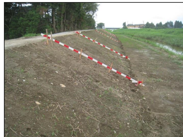
左岸護岸工施工状況 (連節ブロックの上に覆土を施工中)
