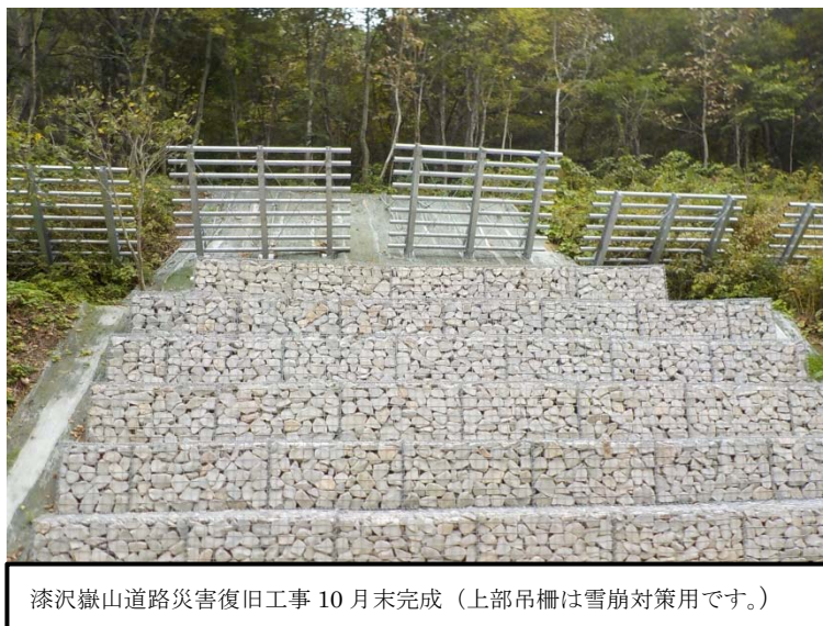
重力式落石防護柵工 完成
