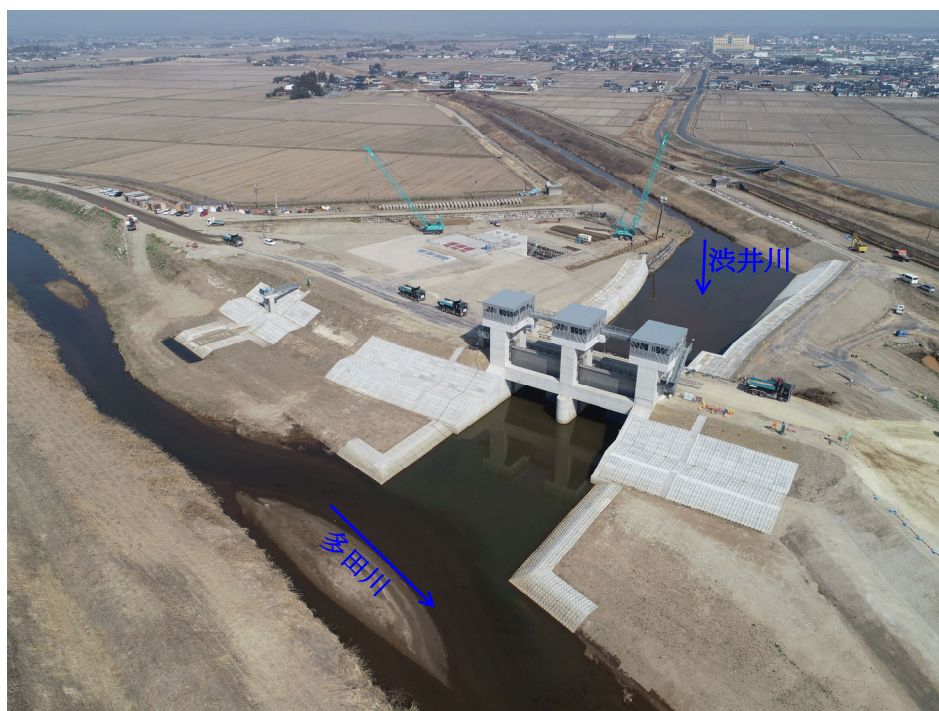
水門工事現況写真
