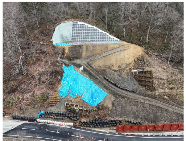
施工中（R7.12.2時点）
