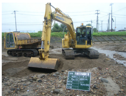
堆積土砂撤去
