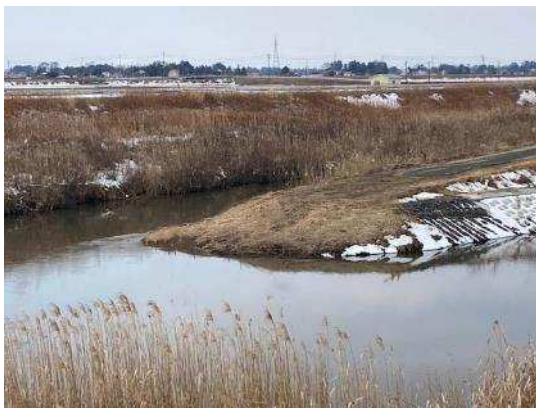
着工前 (令和4年12月)
