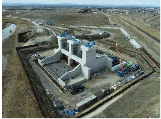
水門本体 施工中 (3月)
