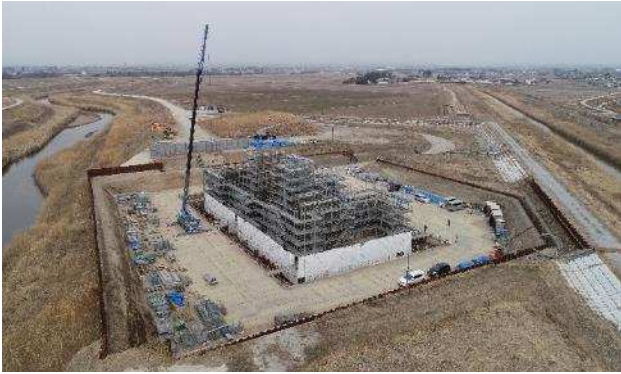
水門本体 施工中 (4月)
