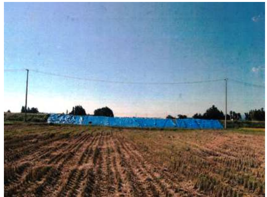
応急復旧工事完了
