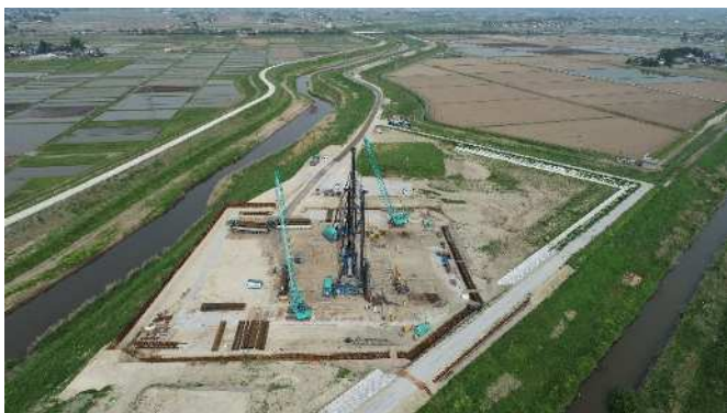
水門基礎 施工中 (4月)
