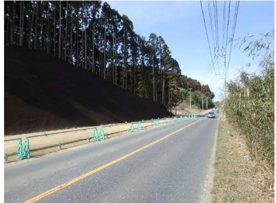
今年度工事完了 (3月)
