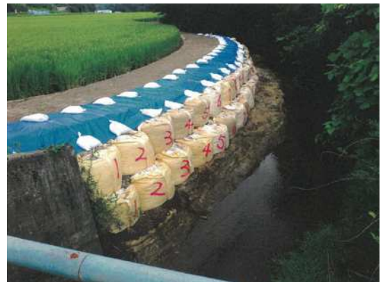
応急復旧工事完了
