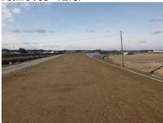
今年度工事完了 (2月)
