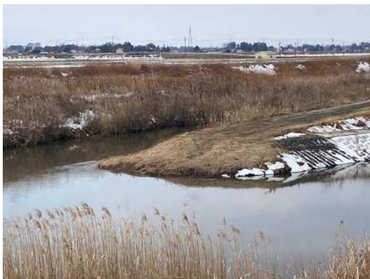
今年度工事着工前 (12月)
