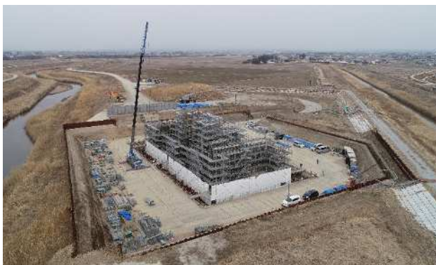
水門本体 施工中 (3月)
