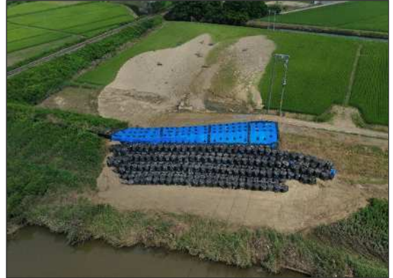
応急復旧工事完了
