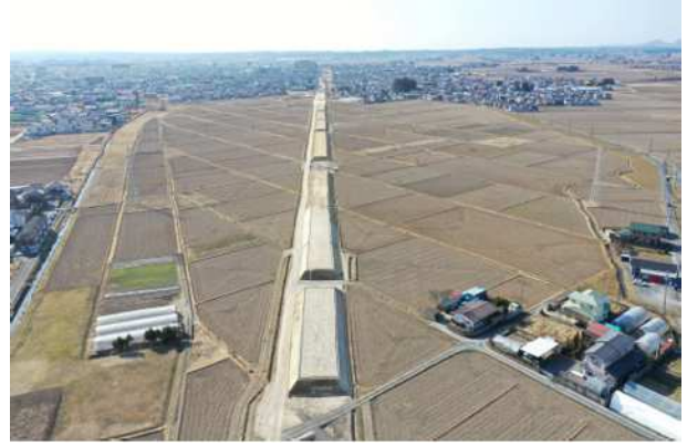
今年度工事完了 (3月)
