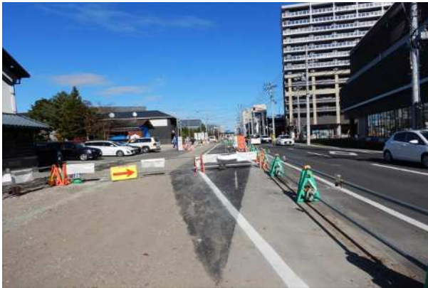
今年度工事着工前 (4月)
