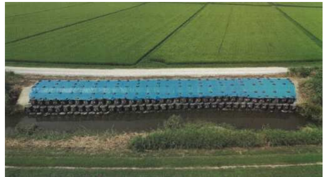
応急復旧工事完了
