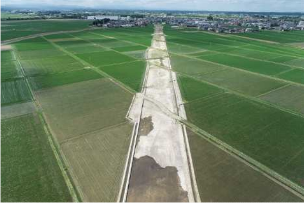
今年度工事着工前 (4月)
