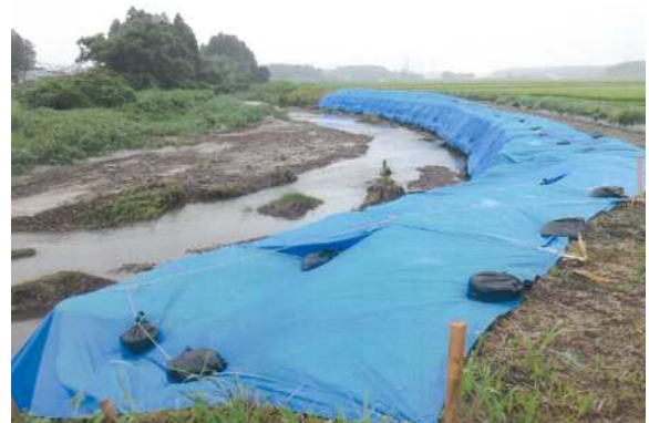
応急復旧工事完了
