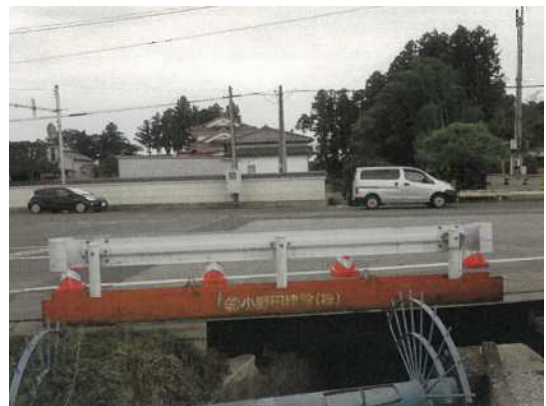
応急復旧工事完了
