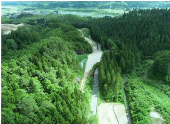
今年度工事着工前 (6月)
