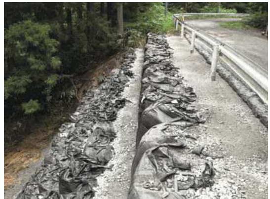
応急復旧工事完了
