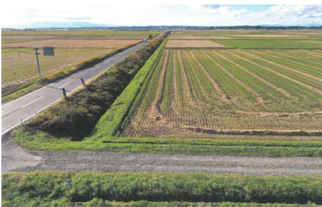
着工前 (令和3年10月)
