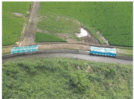
応急復旧工事完了
