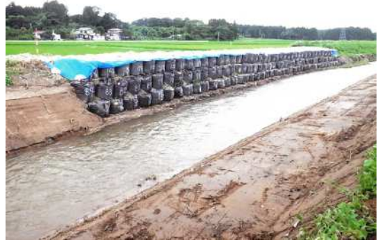
応急復旧工事完了
