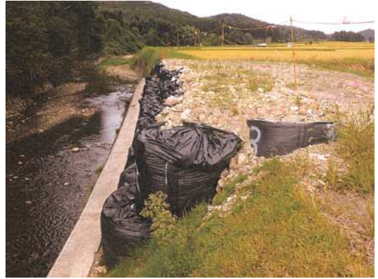
応急復旧工事完了
