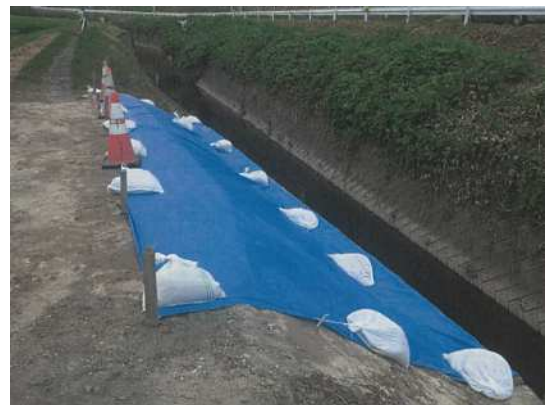
応急復旧工事完了
