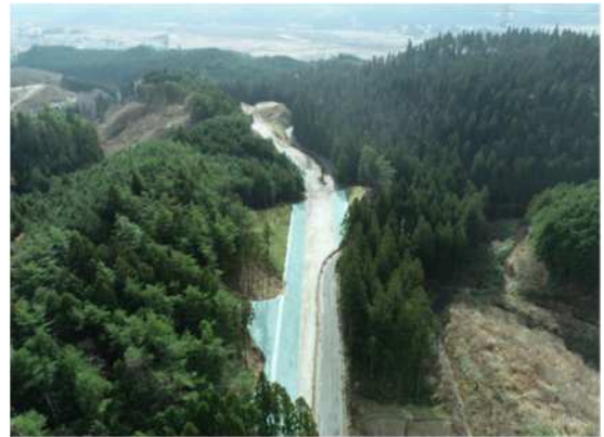
今年度工事完了 (12月)
