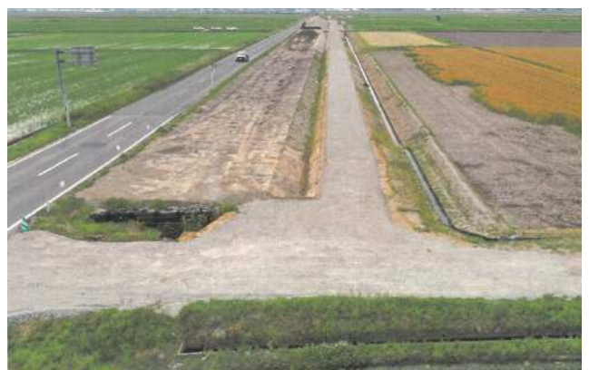
盛土工一部完了 (6月)
