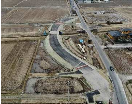
今年度工事着工前 (4月)
