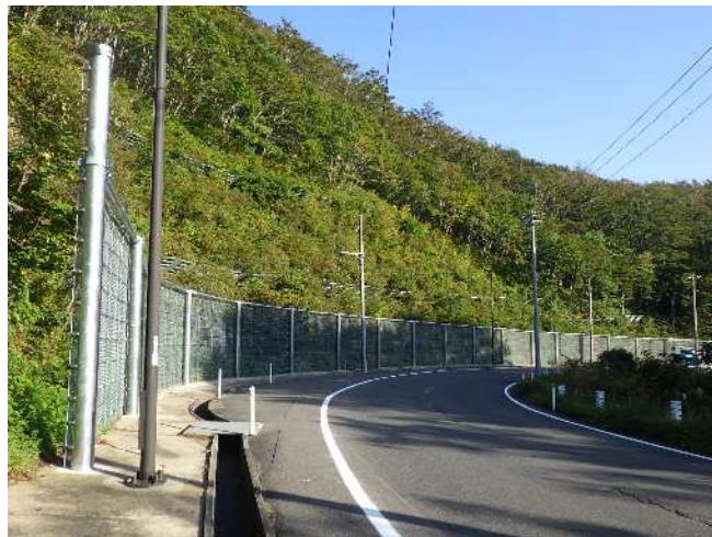
完成 (R7年10月) 雪崩防護柵設置
