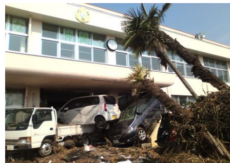
津波に流され玄関に突っ込んだ車
