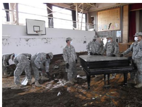
泥をかき出してくれた米軍
