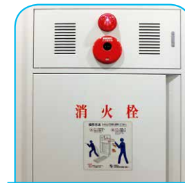
か さい ほう ち き 火災報知器 しょう か せん 消火栓
