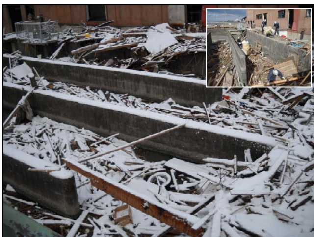
被災状況（H23.3.17撮影）
