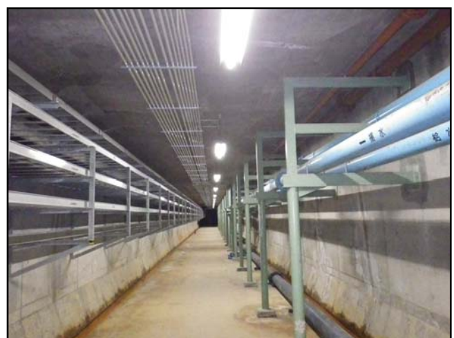
復旧状況 (瓦礫撤去・照明器具)
