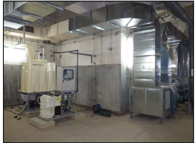
復旧状況 (換気ダクト等)
