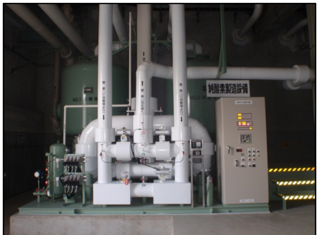
復旧状況 (純酸素発生装置)
