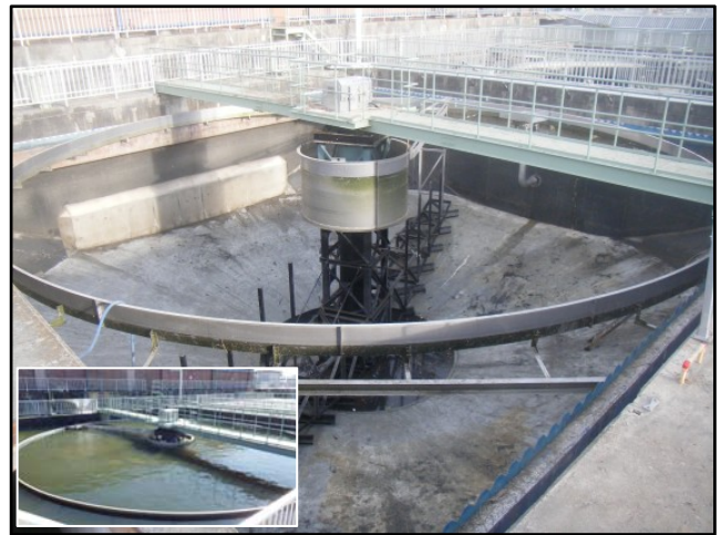
復旧状況 (1系-1 瓦礫撤去・汚泥掻寄機)
