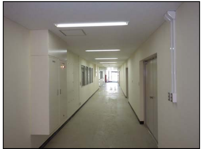
復旧状況 (瓦礫撤去・照明設備等)
