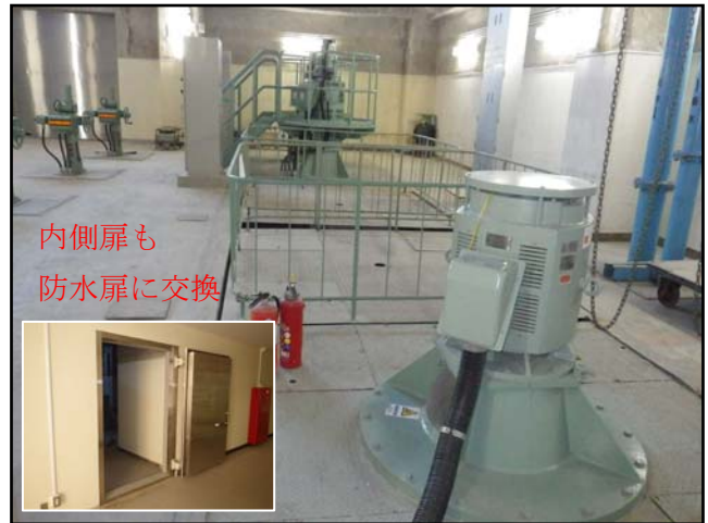
復旧状況 (モーター・防水扉)
