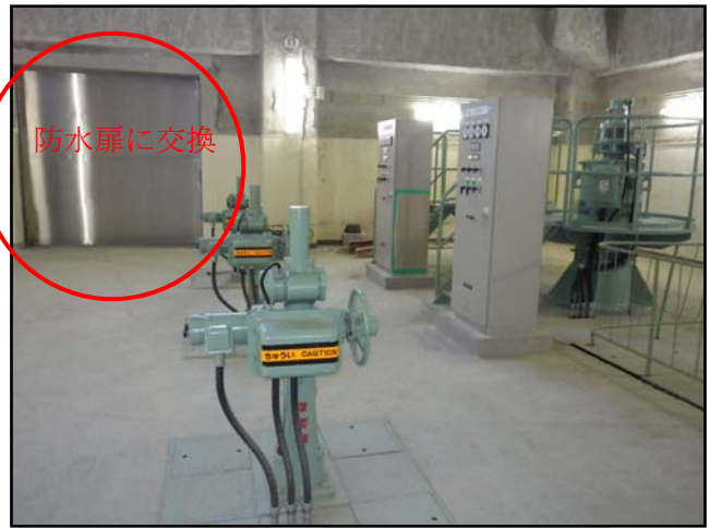
復旧状況 (吐出弁・現場盤・防水扉)
