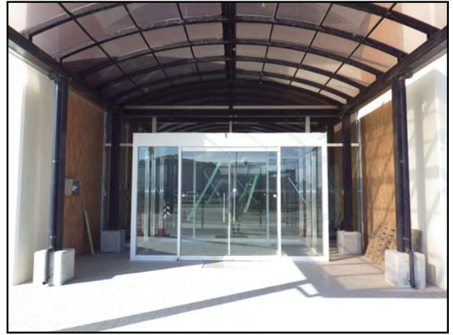
復旧状況 (瓦礫撤去・風除室)
