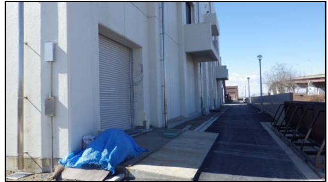
復旧状況 (シャッター・門扉・舗装等)
