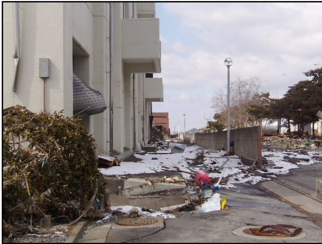
被災状況 (H23.3.18 撮影)
