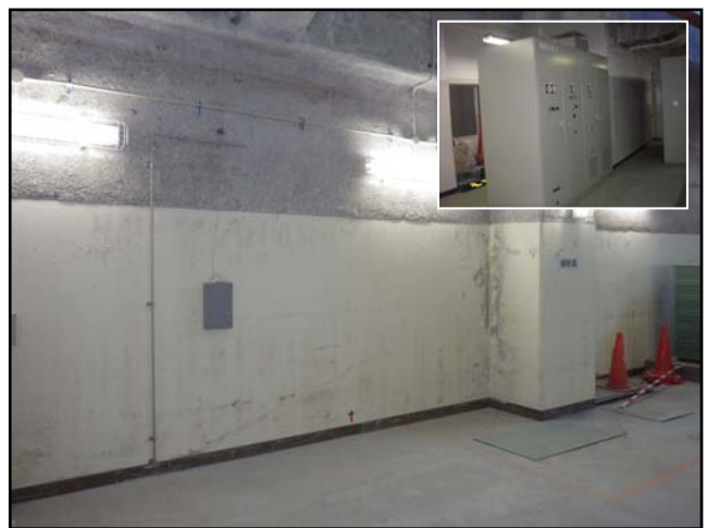
復旧状況 (インバータ盤を2階電気室へ設置)
