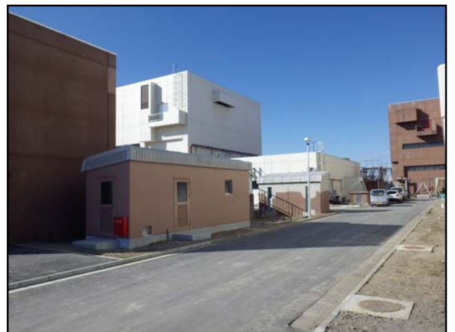
復旧状況 (ガスボンベ庫・油倉庫・舗装等)
