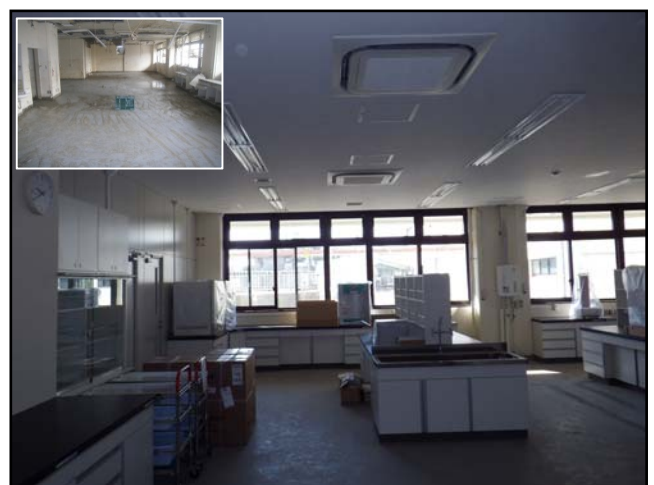
復旧状況 (瓦礫撤去・検査機器)
