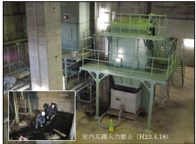
復旧状況 (左: No.1 自動除塵機・右: No.2 沈砂掻揚機)
