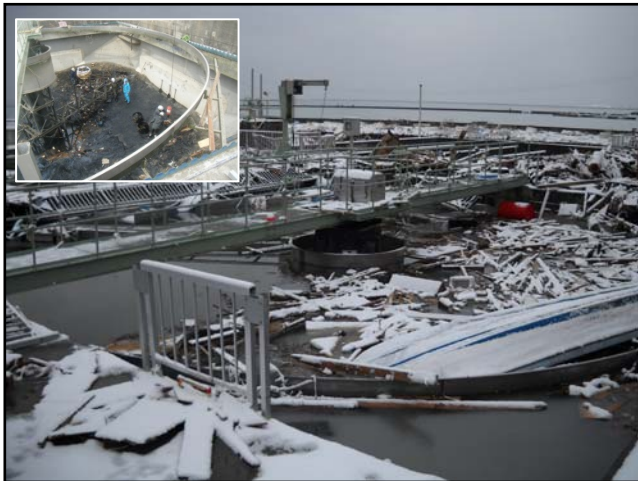
被災状況 (H23.3.17 撮影)
