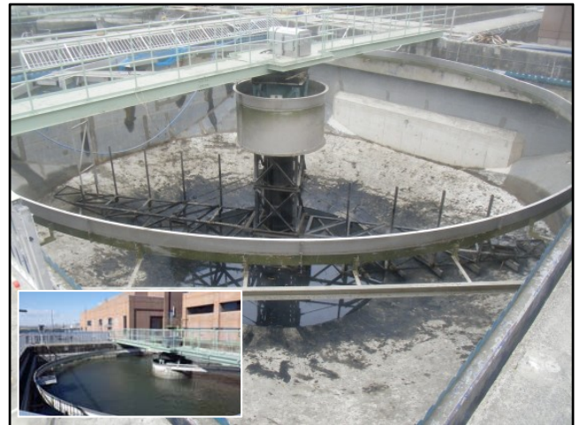
復旧状況 (1系-2 瓦礫撤去・汚泥掻寄機)
