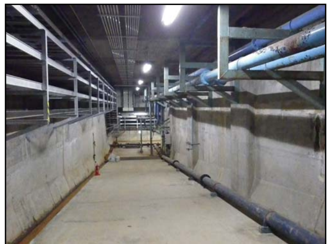
復旧状況 (瓦礫撤去・照明器具)
