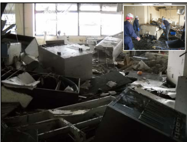
被災状況 (H23.3.17 撮影)
