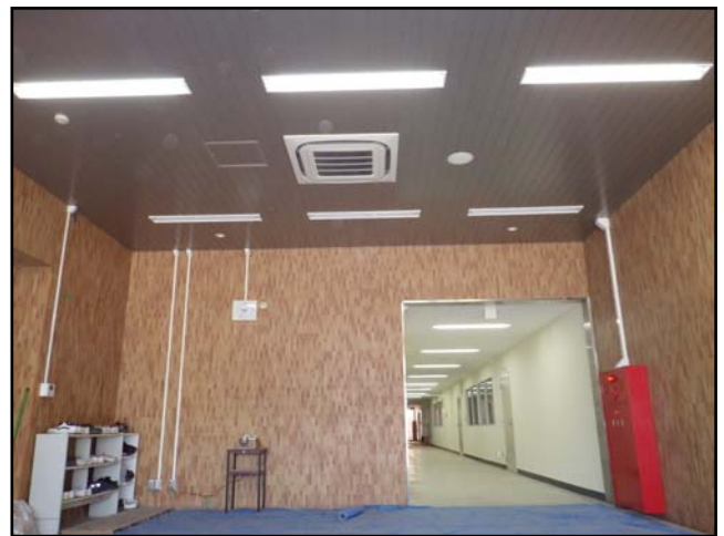
復旧状況 (照明器具・火報設備等)
