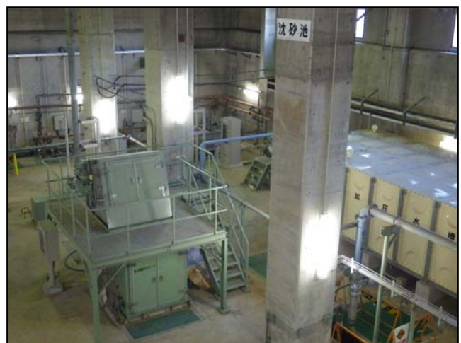
復旧状況 (左: No.2 自動除塵機・右: 加圧水槽)
