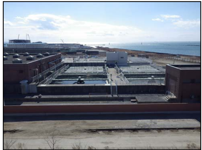
復旧状況（H25.2.22撮影）
