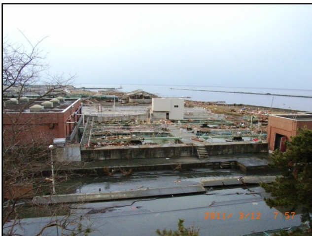
被災状況（H23.3.12撮影）
