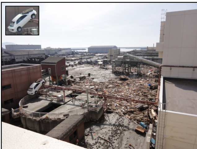
被災状況（H23.3.14撮影）
