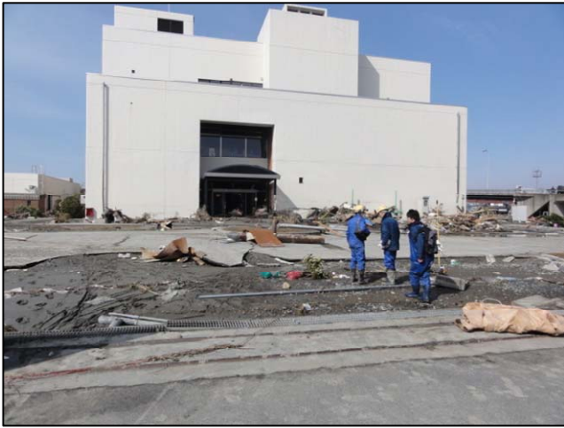
被災状況（H23.3.14撮影）
