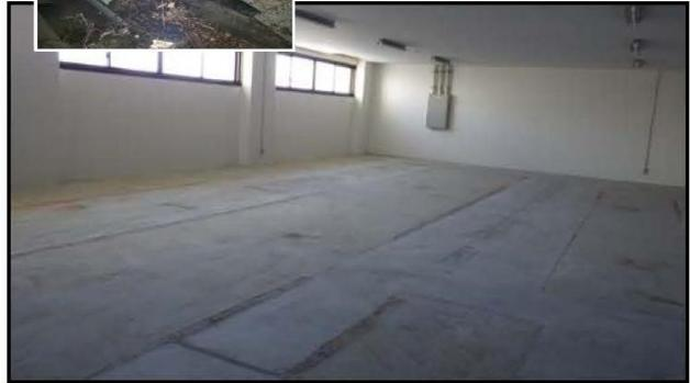
復旧状況 (瓦礫撤去・電気室を2階へ移設)
