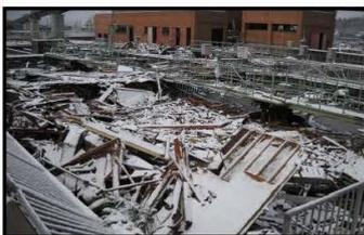
④最終沈殿池(水没)
