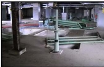
②最初沈殿池(浸水・泥堆積)
