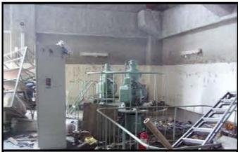
①沈砂池(主ポンプ水没)
