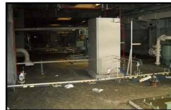
③反応タンク1・2系(浸水・泥堆積)
