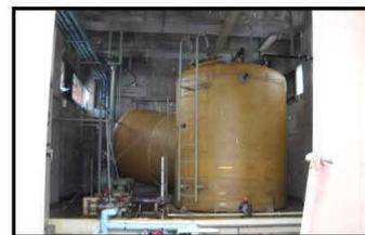
⑤消毒設備(水没・タンク倒壊)
