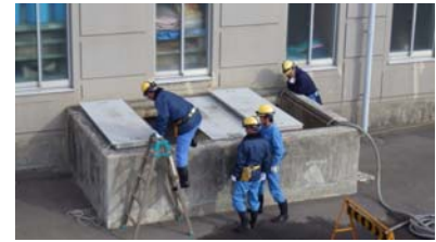
導水管の切替え作業
