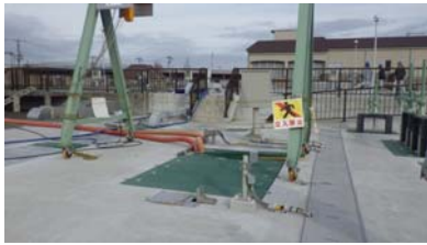
反応タンクへの種汚泥の移送 (2系側)
