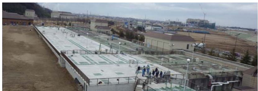
復興が進む石巻市内を背景とした石巻浄化センター
