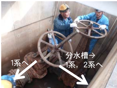
導水管の切替え作業
