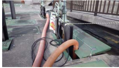
反応タンクへの種汚泥の移送 (1系側)
