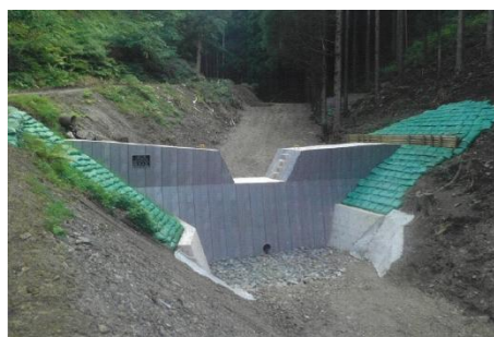
巳の口沢予防治山工事
