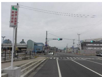
魚市場隣の陸閘と乗越道路
